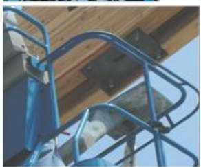
□支圧プレート：柔らかく、めりこみに弱い南国の杉に対して支圧面積が大きくなるようにプレートで梁を受ける(左)。
