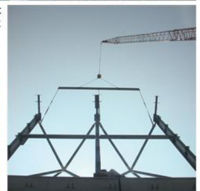
□柱の据え付け：三連柱の地組された鉄骨の揚重、据え付け
