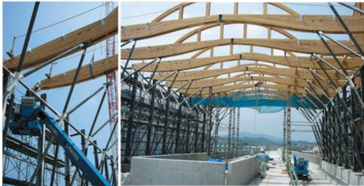
□支圧プレート：柔らかく、めりこみに弱い南国の杉に対して支圧面積が大きくなるようにプレートで梁を受ける(左)。
