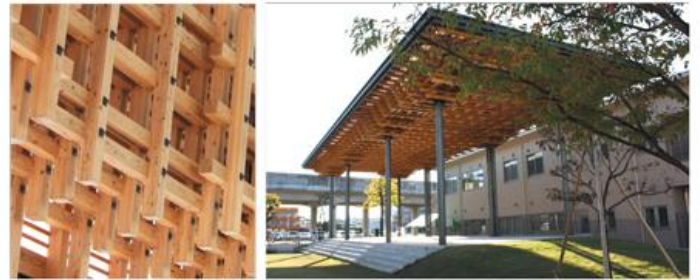
□柱頭部(左)と全景(右)天井から漏れる光が架構のシルエットをきれいにつくっている
