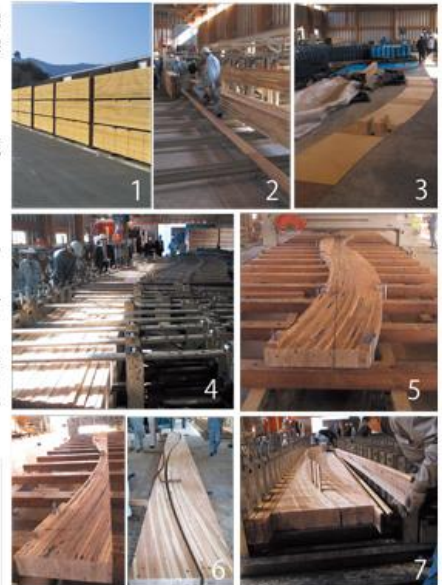
□変断面集成材の製造工程
