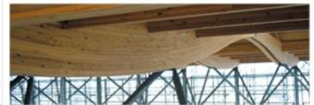
□変断面集成材梁を横から見る
