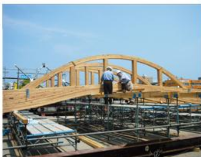
□工場で右上写真の梁を組立、最終形は搬入限界を超えるため現場で組立てられる。
