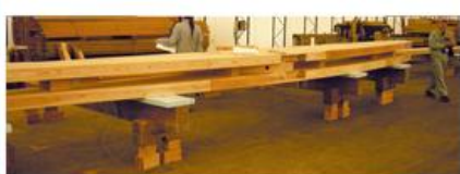
□支圧プレート：柔らかく、めりこみに弱い南国の杉に対して支圧面積が大きくなるようにプレートで梁を受ける(左)。
