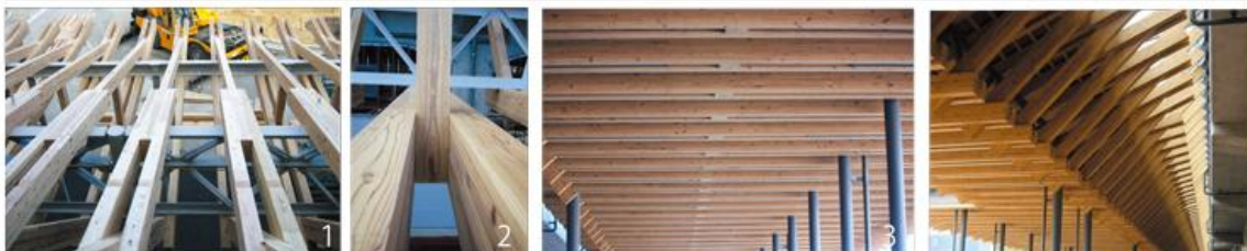
□1. キャノピー架設時、コッタープレートが見える。2. 梁を刻み込みなして接合している。3. 連続する梁。4. キャノピー内観：小屋組を構成する集成材同士の仕口および上弦材の継手には、構造設計者がコッター(楔)プレートと呼ぶ接合方法を開発。これは厚さ3.2mmのコッタープレートを、工場で精度良く加工されたスリット(隙間)に現場でたたき込むものである。プレート全体でせん断力を伝達するので、木材に負担をかけないせん断伝達接合方法である。
