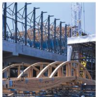
□工場で右上写真の梁を組立、最終形は搬入限界を超えるため現場で組立てられる。
